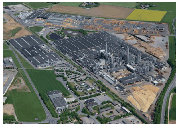
1: Около года назад завод Эггер в Брилоне (Германия) установил первые Satos plus с 10-ю шлифовальными головками.
