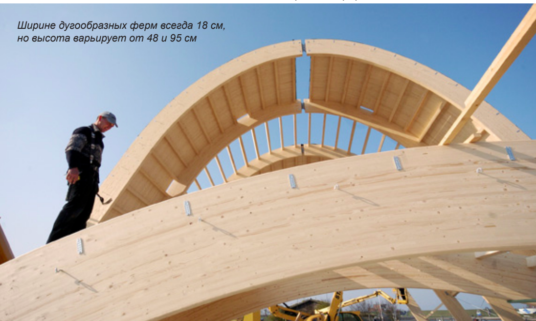
Искривленные прогоны в «пасти» кита были изготовлены по отдельности вручную. Здесь в качестве соединителя использовался «Gigant»
