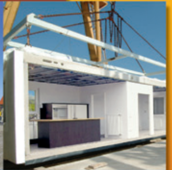
9:00 - Монтаж первого этажа
